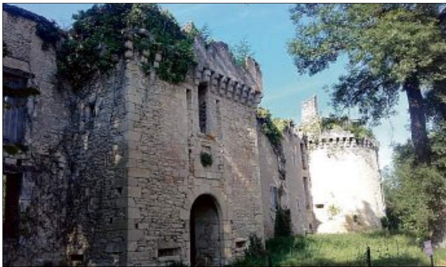
MARQUEYSSAC. Les vestiges du château font aujourd'hui l'objet de plusieurs phases de travaux.
